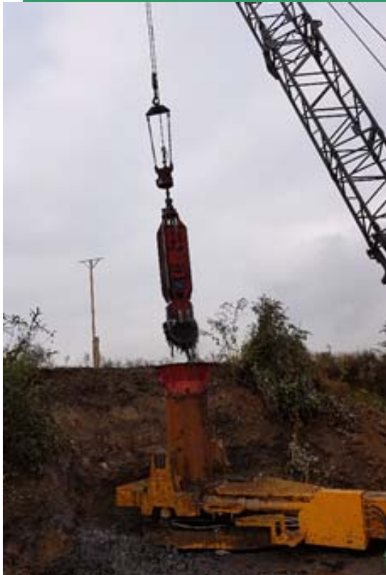
Bauausführung der neuen GB, Firma Hölscher
